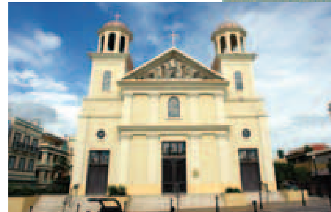
A través de la fachada principal, hay tres accesos a su interior. (Eric Quiñones)
