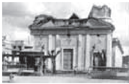
Las instalaciones de la Catedral han sufrido diversos embates. (Suministrada)
