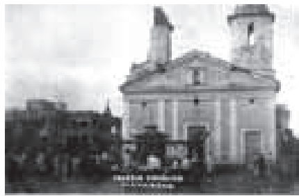
Antigua vista de la estructura. (Suministrada)
